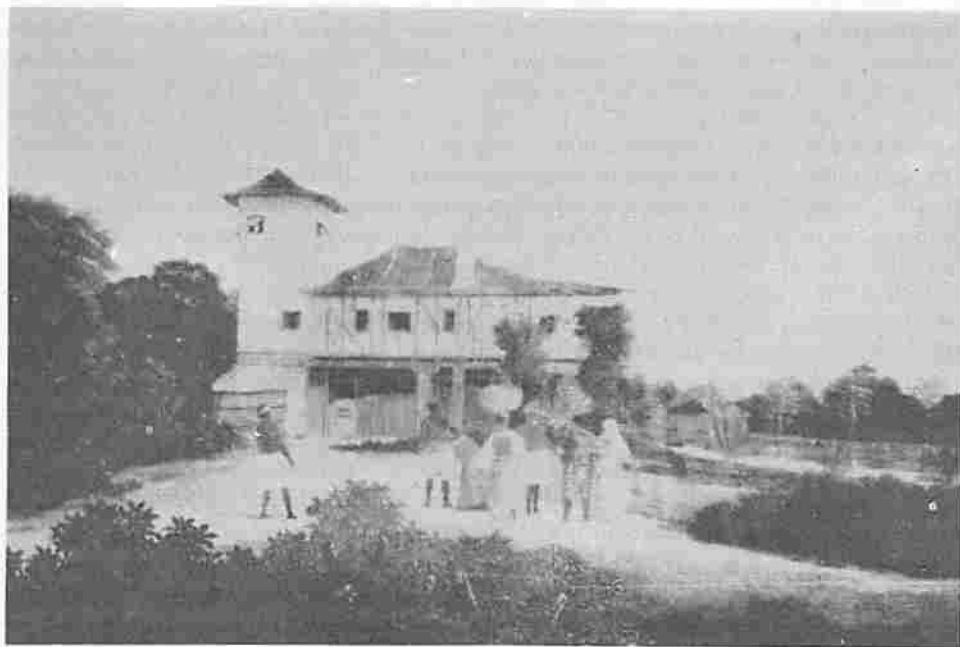
Figura 2. A torre contígua a esta casa-grande evidencia a função defensiva dos engenhos nos primórdios da colônia. Os aposentos do proprietário frequentemente situavam-se no segundo andar.
