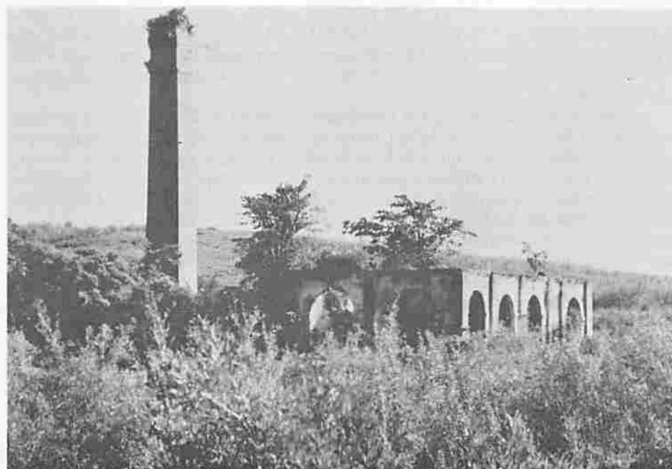
Figura 7. Tudo o que resta do Engenho Sergipe do Conde, "Rainha do Recôncavo". (A chaminé foi instalada no século XIX, acompanhando a introdução de moendas a vapor.)
